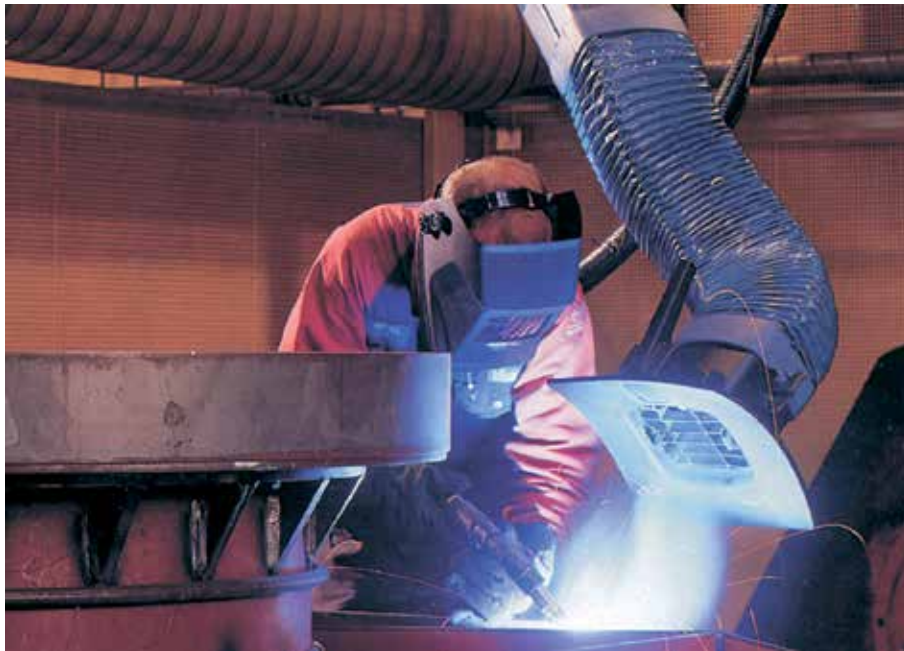
Fig. 10 Eksempel på punktudsugning med svingarm af lavtrykstypen
