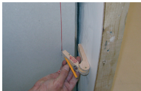
Figur 12.31 Forstrykning med andenæb.
