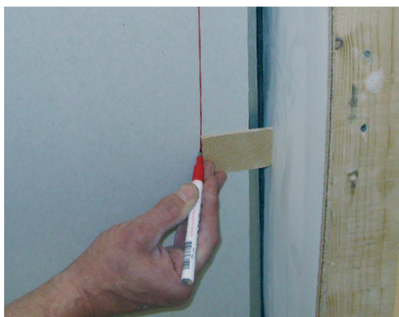
Figur 10.14 Forstrygning med klods.
