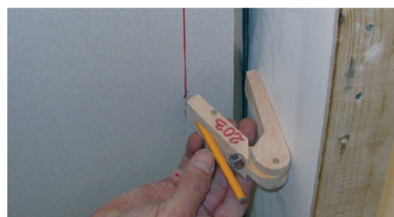
Figur 10.16 Opmåling og placering af sidste plade til forstrygning.
