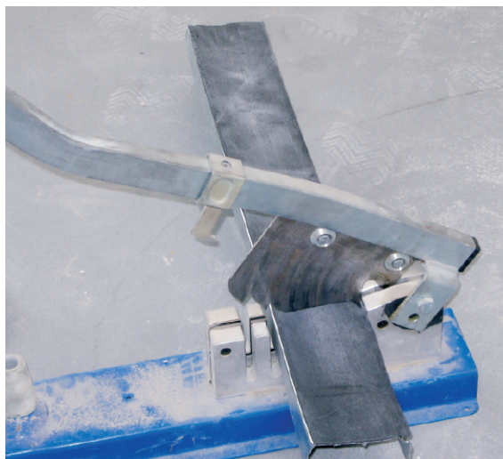
Figur 12.41 En skinne klippes med profilsaks.
