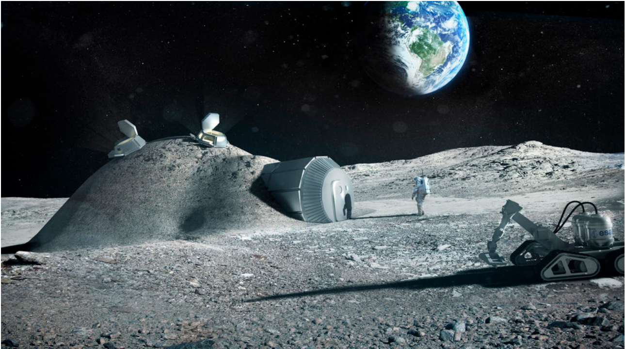
Det europæiske rumagentur ESAs forslag til en månebase viser problemerne ved at bo på Månen: Af hensyn til stråling og de ekstreme temperaturer fra -180\text{ }^{\circ}\text{C} om natten til over 100\text{ }^{\circ}\text{C} om dagen skal basen dækkes af et tykt lag månesteov. Kilde: ESA
